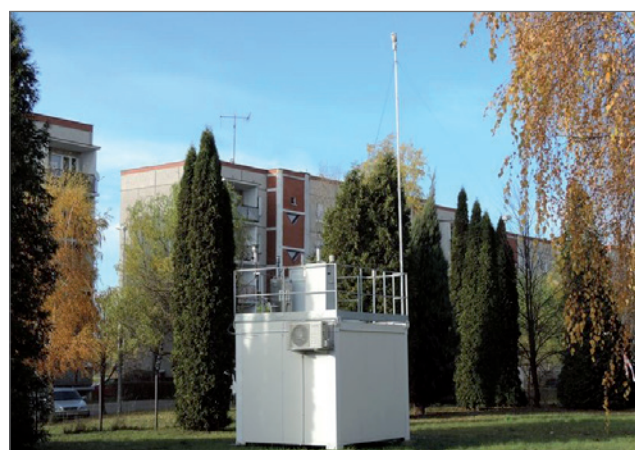
Stacja monitoringowa w Zamościu przy ul. Hrubieszowskiej
