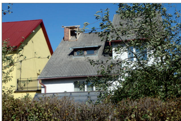
Poszycie dachu z płyt azbestowych
