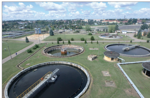
Oczyszczalnia ścieków w Łukowie
