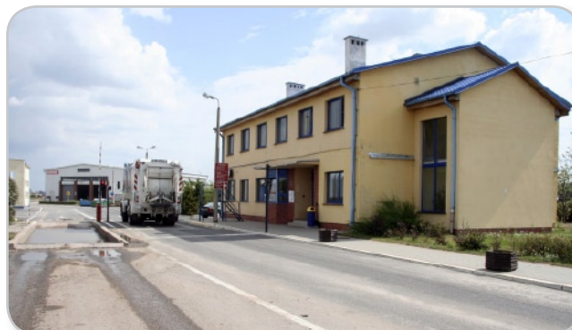
Infrastruktura na składowisku odpadów komunalnych
