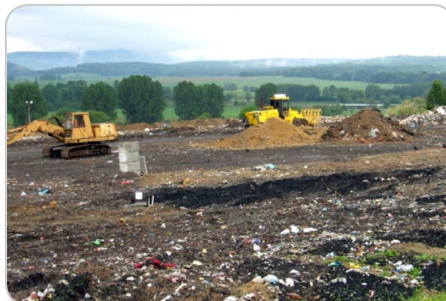
Składowisko odpadów komunalnych
