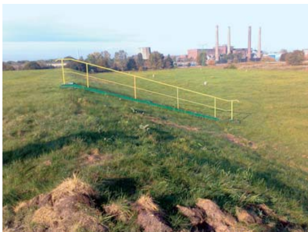
Zrehabilitowane Składowisko Odpadów Poremontowych i Komunalnych zlokalizowane na terenie Grupy Azoty ZAK S.A. Po prawej stronie widoczne kominki odpowietrzające biernego systemu odgazowania złoża kwatery przeznaczonej na odpady komunalne, po lewej (wyżej)kwatery odpadów poremontowych.
