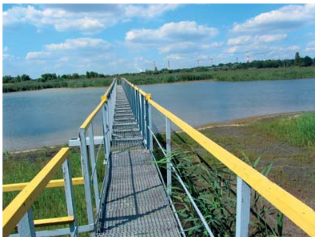
Składowisko odpadów ArcelorMittal Poland S.A. Oddział w Zdzieńkowicach Podest obsługowy wokół punktu napływu wody nadosadowej (mnich nr 1), widok na kwaterę 2B od strony południowej
