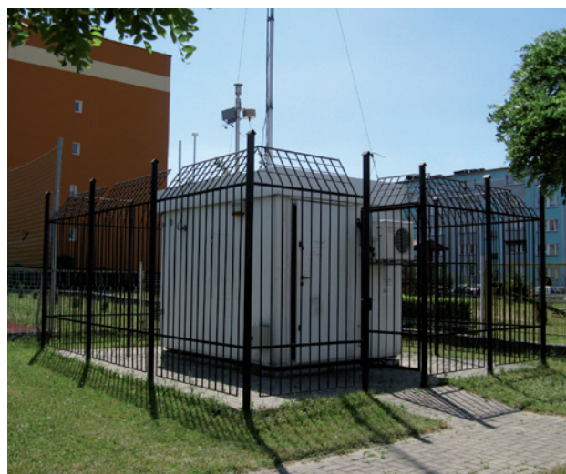
Stacja automatyczna w Zdzieszowicach
