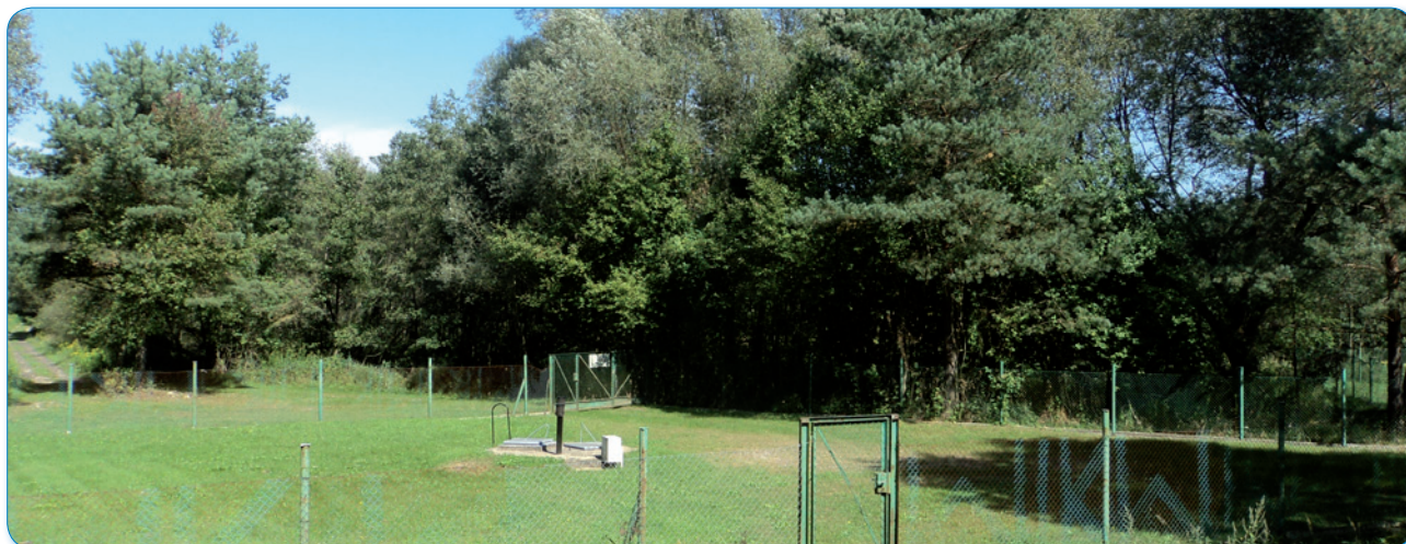
Ujęcie wód podziemnych w Zawadzie
