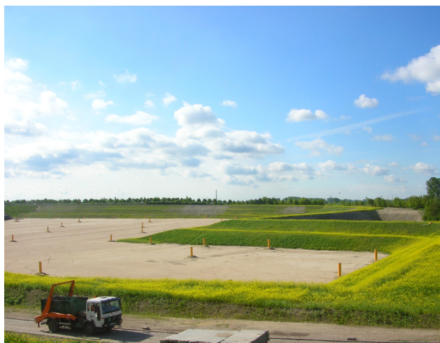
Widok na kwaterę składowiska odpadów Zakład Komunalny Sp. z o.o. w Opolu
