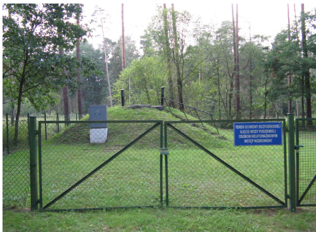
Ujęcie wód podziemnych w Zawadzie
