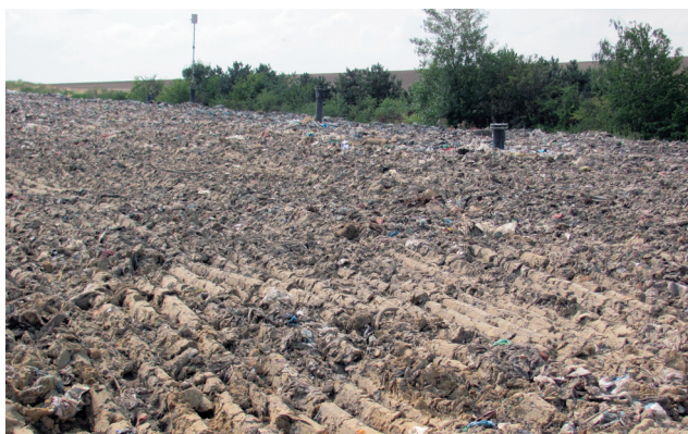
Rozbudowa Zakładu Zagospodarowania Odpadów w Dzierżysławiu
