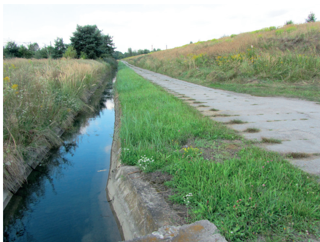
Składowisko odpadów ArcelorMittal Poland S.A. Oddział w Zdzieszowicach (po lewej rów opaskowy wokół składowiska, po prawej skarpa zewnętrzna kwater A oraz B składowiska Nr 2)
