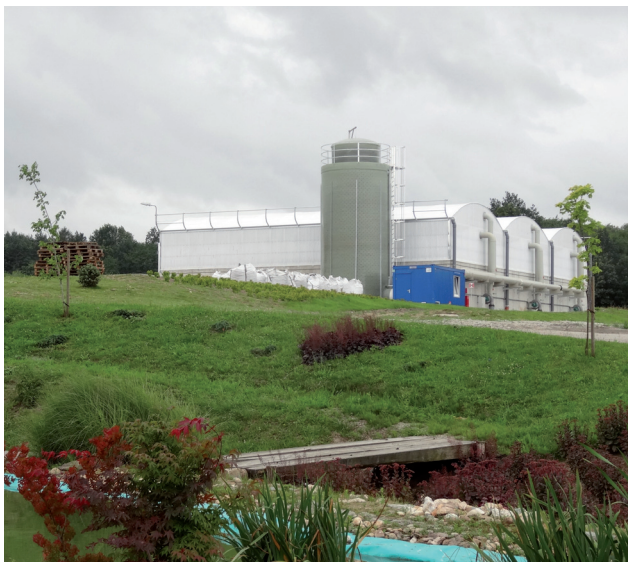
Instalacja Biologicznego Przetwarzania Zmieszanych Odpadów Komunalnych Regionalne Centrum Gospodarowania Odpadami – Nysa w Domaszkowicach EKOM Sp. z o.o. w Nysie
