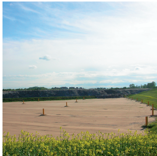
Widok na kwaterę składowiska odpadów w Opolu Zakład Komunalny Sp. z o.o. w Opolu
