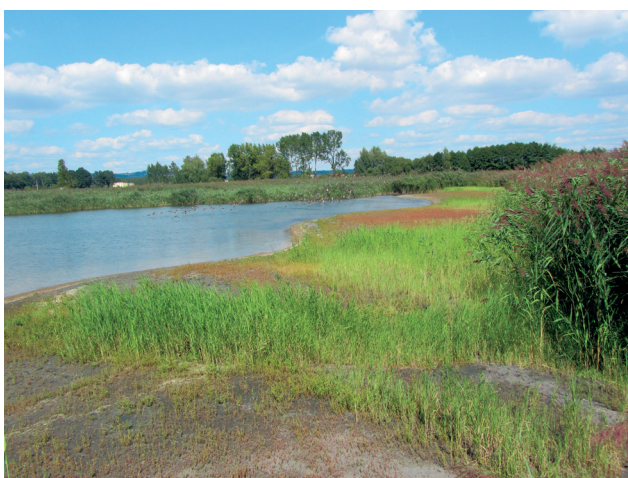
Składowisko odpadów ArcelorMittal Poland S.A. Oddział w Zdzieszowicach (widok na kwaterę 2B z korony wału od strony południowej)
