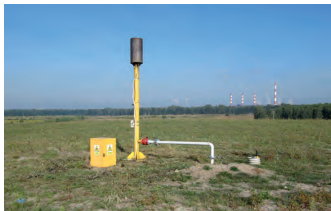
Zrekultywowana kwatera składowiska odpadów w Kędzierzynie-Koźlu
