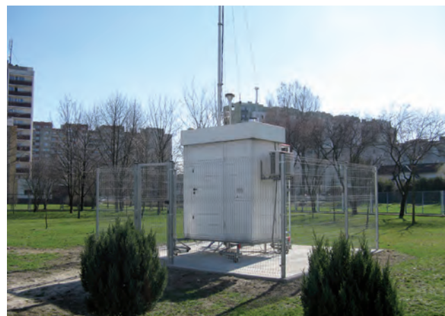
Stacja pomiarowa w Opolu, ul. Koszyka
