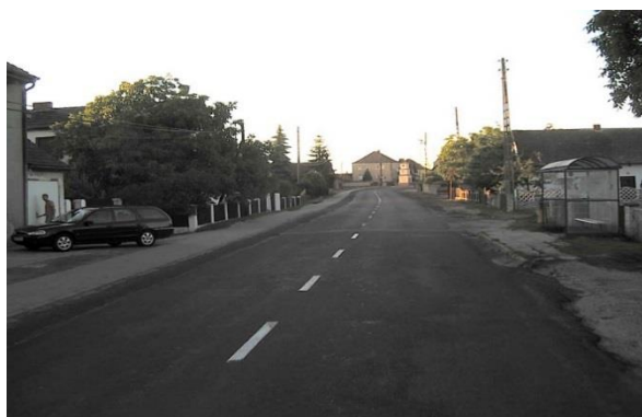
Droga wojewódzka nr 414 przed rozbudową na odcinku Górk-Chrząszczyce (źródło: ZDW w Opolu)
