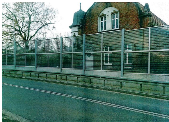
Ekran akustyczny w ciągu drogi krajowej nr 39 w Brzegu (źródło: GDDKiA oddział w Opolu)
