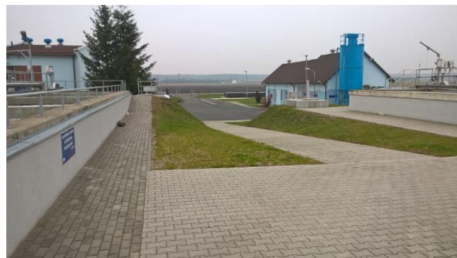
Widok na oczyszczalnię ścieków w Kosorowicach (źródło: Wodociągi i Kanalizacja w Opolu Sp. z o.o.)
