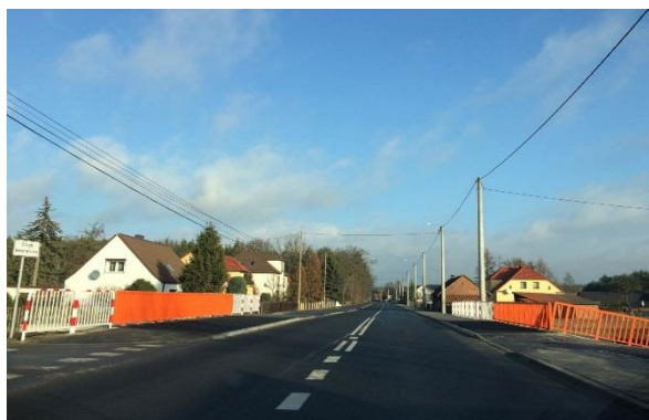
Budowa mostu w ciągu drogi wojewódzkiej nr 454 w miejscowości Kup (źródło: ZDW w Opolu)
