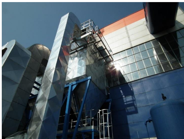
Instalacja do odpylania spalin w ciepłowni w Strzelcach Opolskich (źródło: ECO S.A.)
