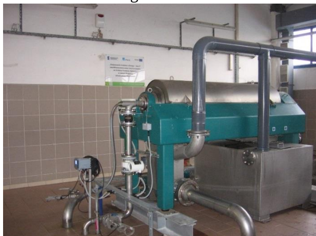
Wirówka dekantacyjna do zagęszczania osadów (źródło: Przedsiębiorstwo Wodociągów i Kanalizacji w Brzegu Sp. z o.o.)
