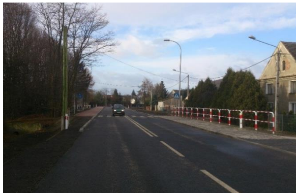
Rozbudowa drogi wojewódzkiej nr 407 w miejscowości Konradowa (źródło: ZDW w Opolu)
