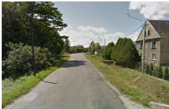
Droga wojewódzka nr 407 przed rozbudową w miejscowości Konradowa (źródło: ZDW w Opolu)
