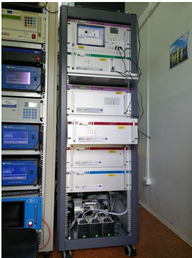
Ryc. 18. Budowa systemu monitoringu prekursorów ozonu AirmoOzone.
